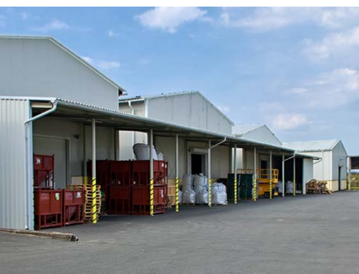
Areál posklizňové linky a skladů ve Vysokém Mýtě
